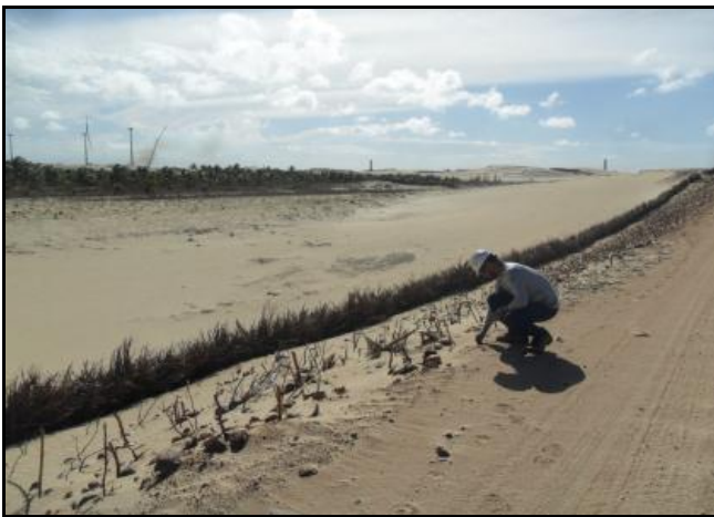
Figura 3 – Contenção lateral a via de acesso interna do parque eólico com uso de palhas de coqueiros para evitar/minimizar a erosão eólica.
