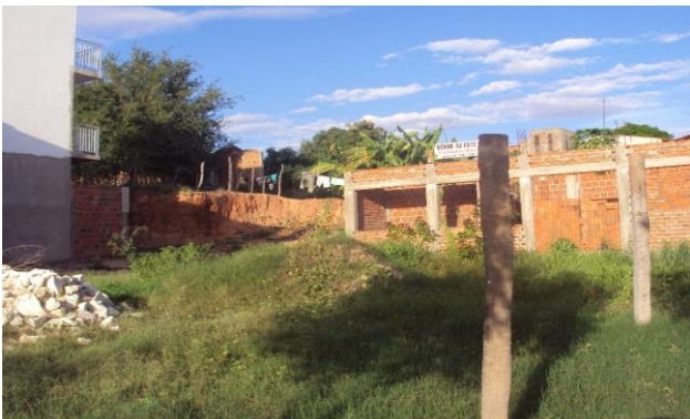
Figura 5: Construção de residências em encostas próximas às margens da Lagoa, Apodi/RN, 2015.
