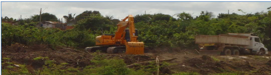
Figura 03: Maquinas trabalhando no local, promovendo ruídos devido aos veículos pesados e remoção da vegetação em áreas de extração da argila da Cerâmica Ceritta. Marabá – PA.
