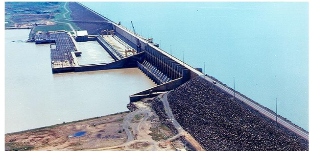
Figura 3 – Usina Hidrelétrica de Ilha Solteira - CESP
