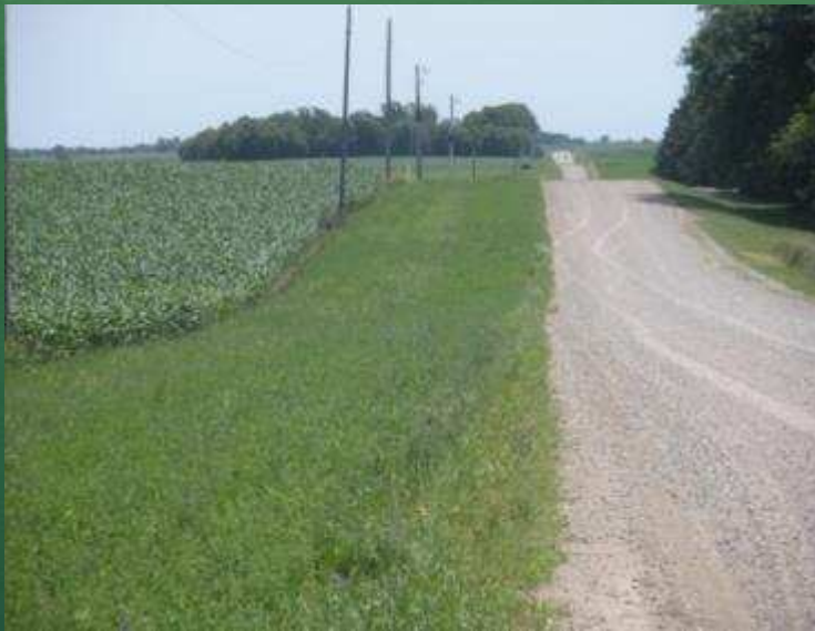
Canaletas de drenagem de estrada vegetada
