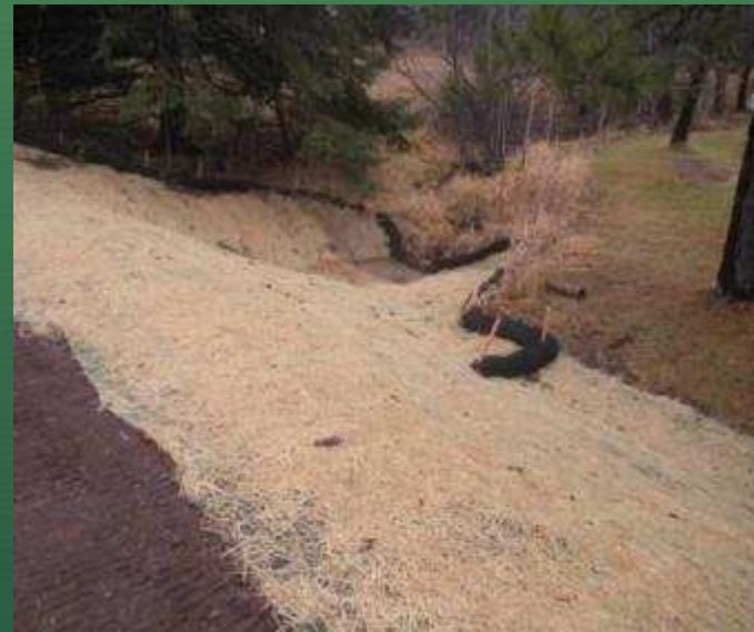
Estrutura para filtragem de sedimentos junto à canaleta de estrada quando essa corta a rede de drenagem
