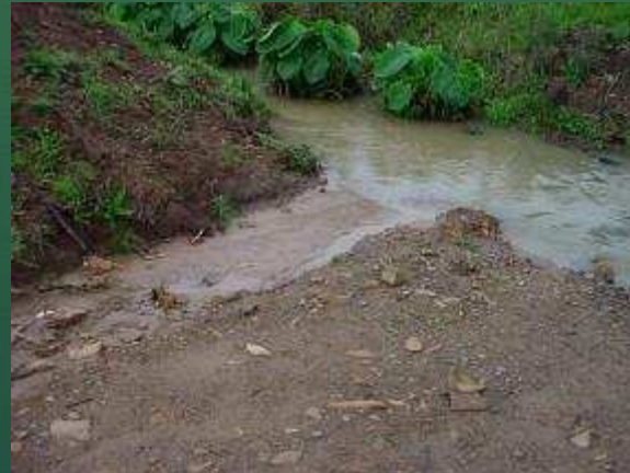
Canaleta das estradas
