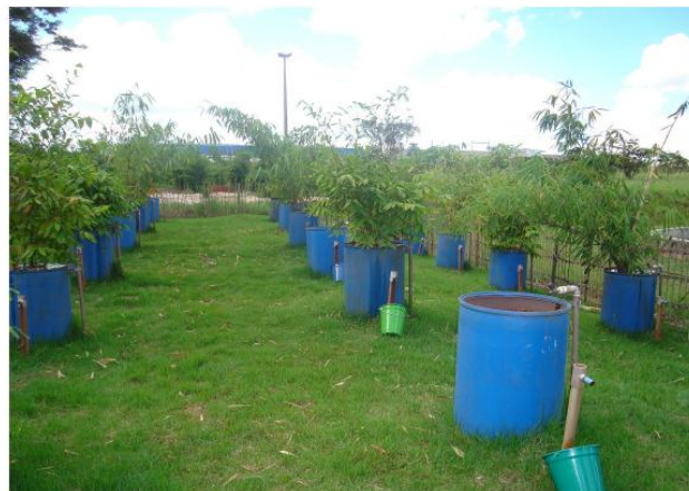
Figura 2 - Vista geral da Estação de Pesquisas em Tratamento de Esgoto com Plantas – EPTEP, Senador Canedo – GO.
