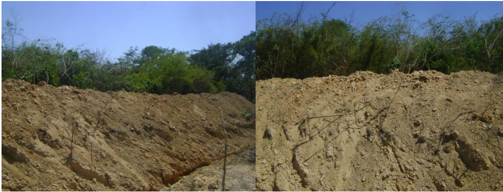
Figura 1: Retirada da vegetação nativa da área de extração da cerâmica Nova Era – Marabá-PA. Fonte: Hentz (2011).
